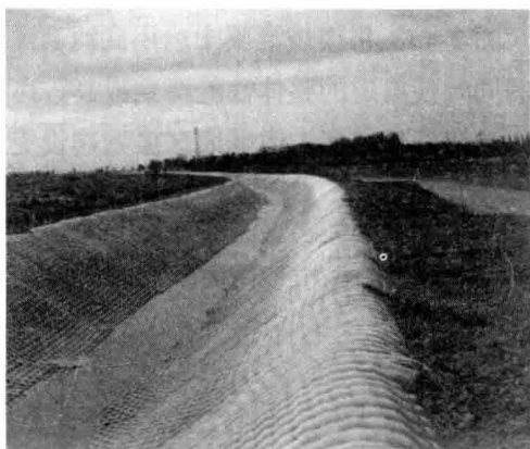
图 1-4 模袋混凝土衬砌渠道
