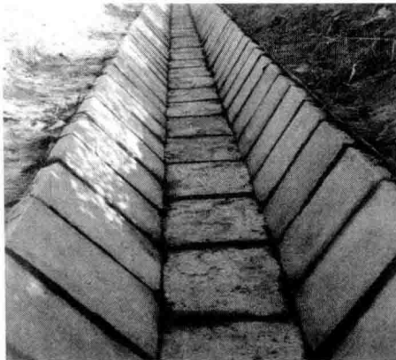
图 1-3 混凝土衬砌板渠道
