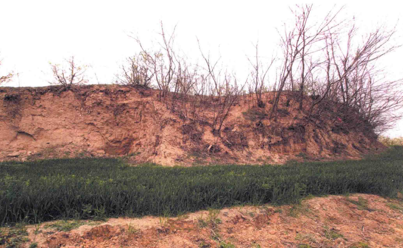
废黄河徐州境内明代遗存大堤
