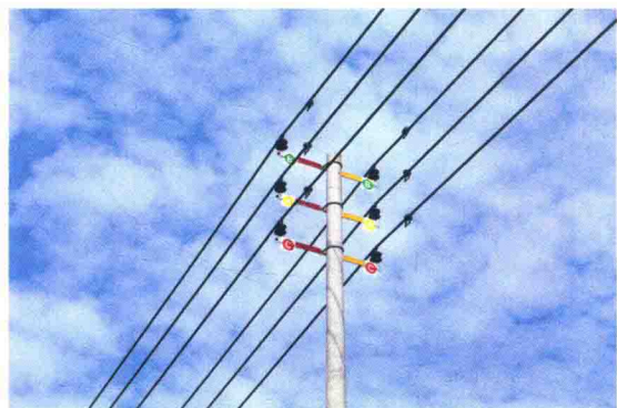
接地挂环安装
