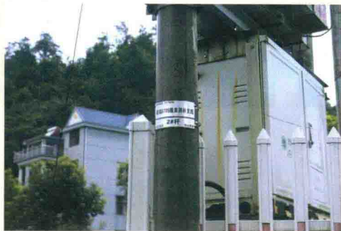
配电箱式变电站更换现场勘察
