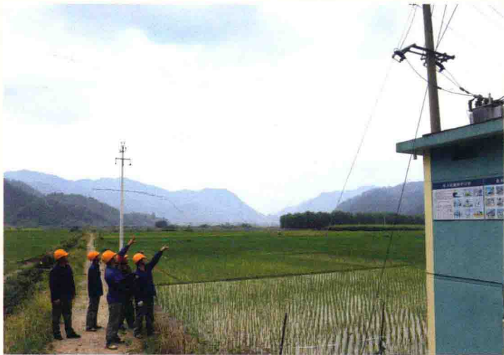
导线架设现场勘察
