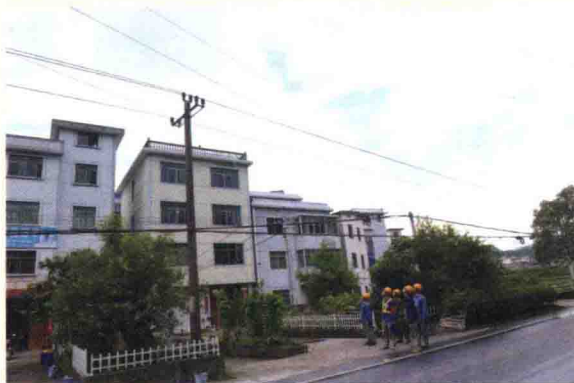
高低压交跨现场勘察
