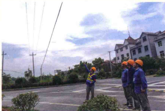
跨越公路现场勘察
