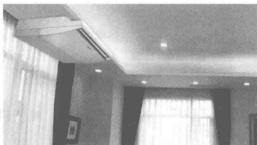
图 1-8 分体吊顶式空调器明装室内机
