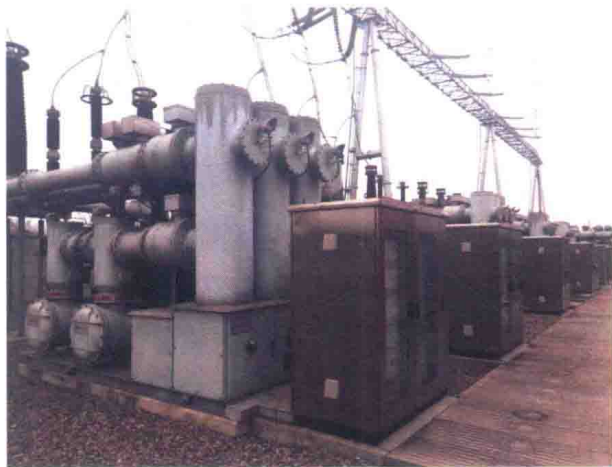
图1-3 智能组件就地集成的智能变电站
