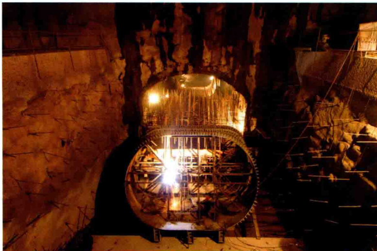
尾水管肘管安装
