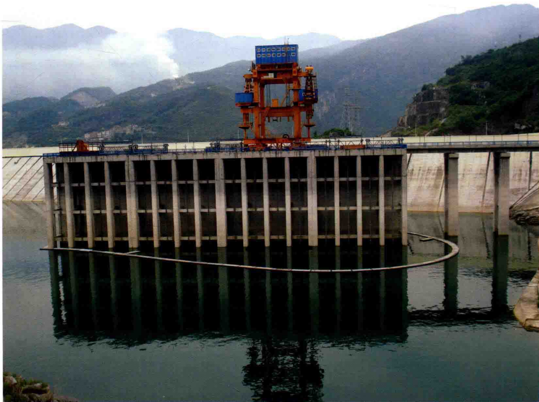
地下电站进水塔
