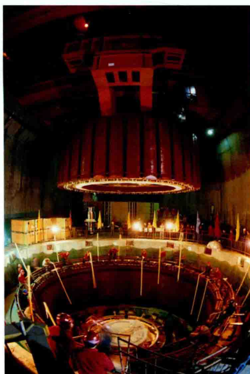
发电机转子吊装
