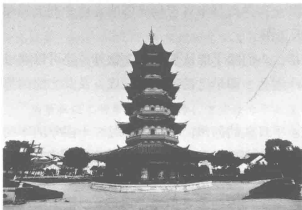
加固维修后的瑞光塔
