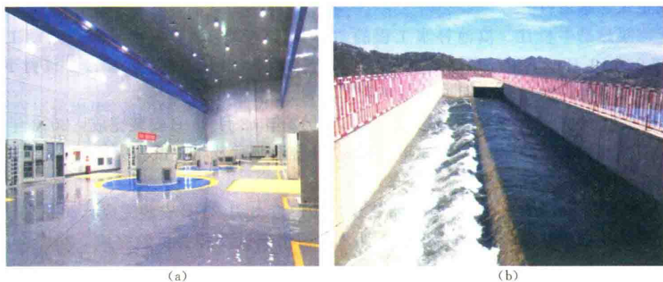
图 1.1-3 干河泵站地下厂房和出水池实景图
