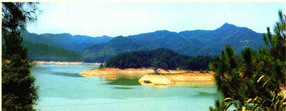
全国最大的土坝工程之一——黄材水库
