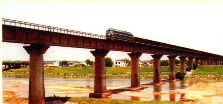
石长铁路沩水特大桥
