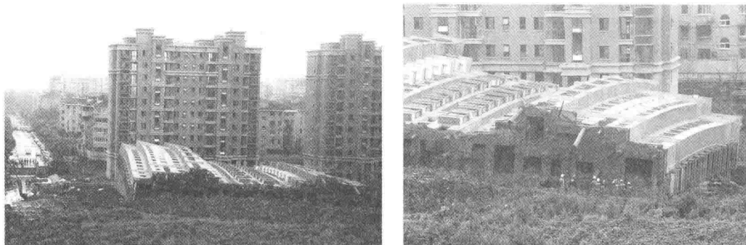
图0-2 上海13层楼房整体倾倒事故
