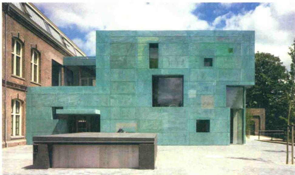
墙上的窗分两种：一种是与通常建筑相同的窗，此种开窗方式形成了内外墙体上的深洞，这种窗既是室内的观景窗，又是墙面上的点缀；另一种是由内外两层穿孔板遮挡起来的半透明的窗洞，它既可以产生丰富的光影效果，同时又是墙面的延伸。
