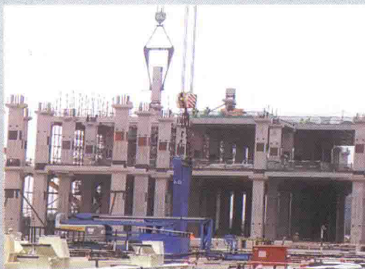
图 C-02 建筑面积 10 万 m^2 的框架结构装配式建筑施工工地
