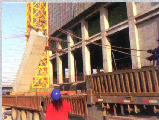
图 C-03 构件从车上直接吊装
