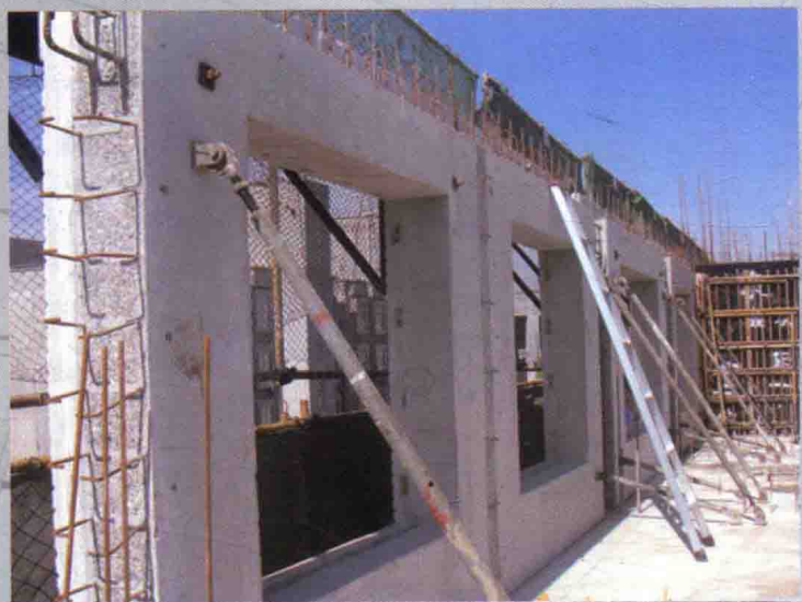
图 C-07 剪力墙临时支撑
