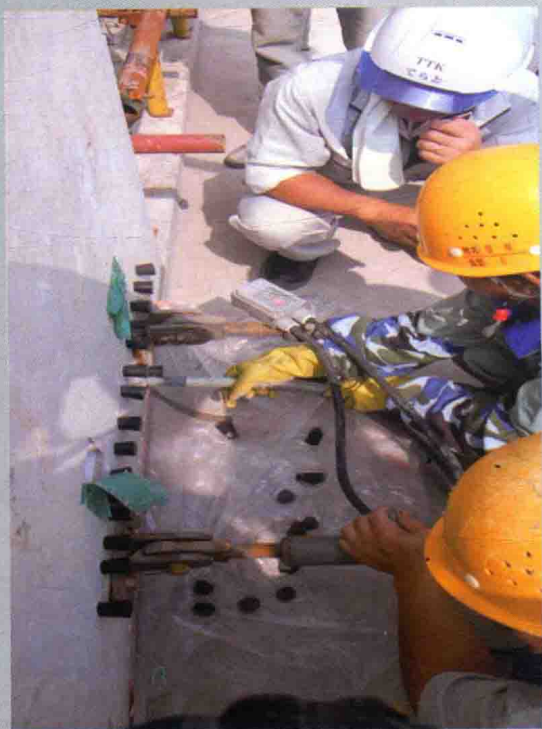
图 C-05 剪力墙结构套筒灌浆作业
