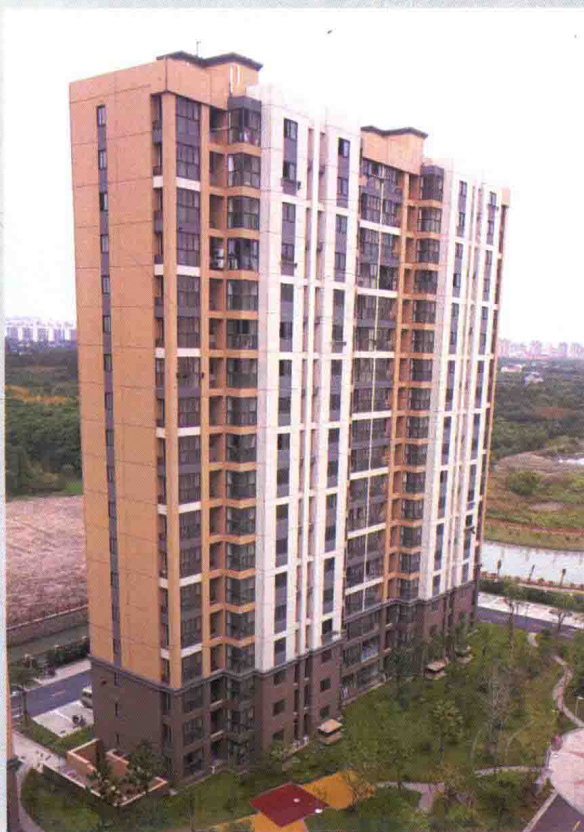
图 C-01 高层剪力墙结构装配式建筑——上海浦江保障房
