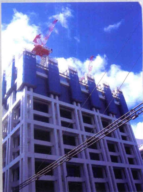
图 C-06 筒体结构外筒构件“零后浇混凝土连接” 的高层装配式建筑——日本鹿岛办公楼
