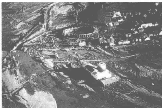
图 1.8 Malpasset 双曲拱坝溃坝破坏
