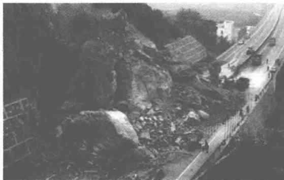
图 1.1 浙江甬台温高速公路大面积山体崩塌事故
