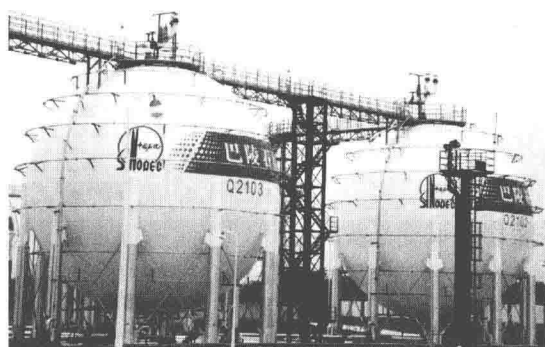
图 1-9 巴陵石化储油罐
