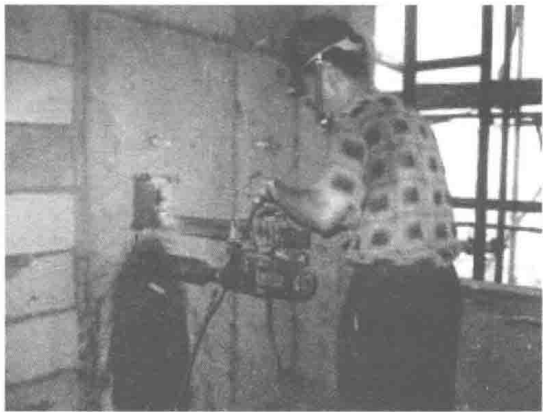
图 1.4 钻芯法测混凝土强度
