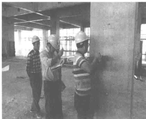
图 1.2 回弹法测混凝土强度
