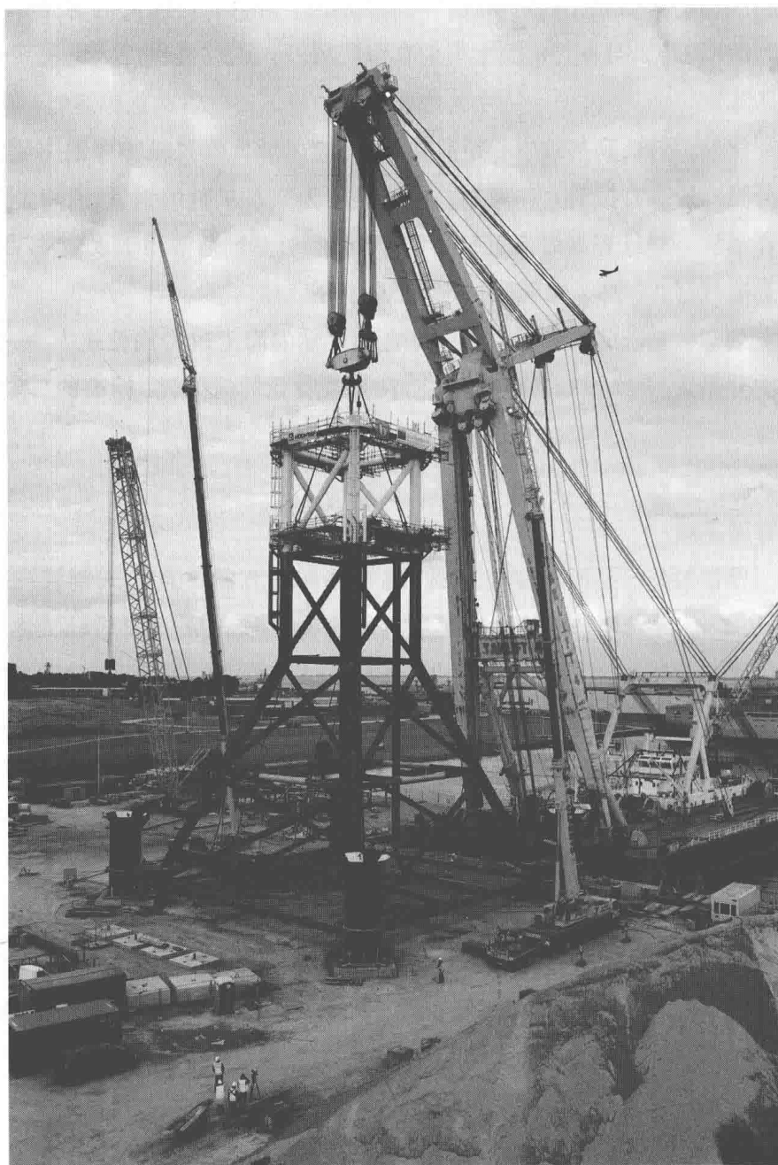
图 1.6 导管架基础在比阿特丽斯试验风电场安装的场景
