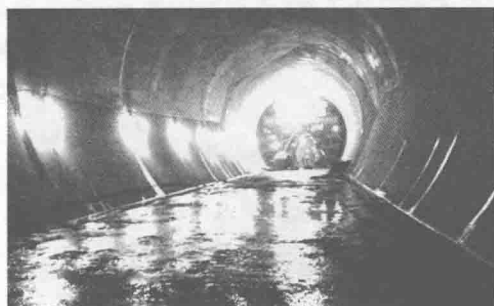
图 1-7 锦屏二级水电站引水隧洞
