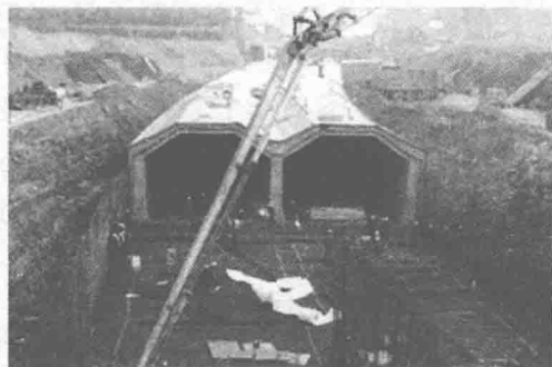
图 1-24 四川遂宁观音湖下穿隧道折板结构
