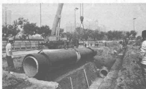
图 1-8 市政管道施工现场
