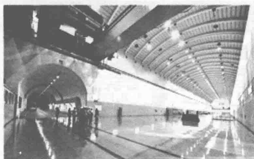
图 1-11 二滩水电站发电车间
