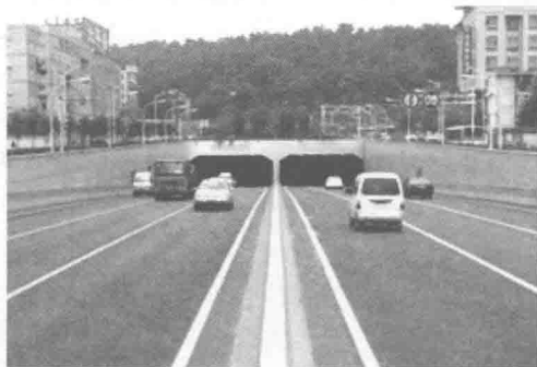
图 1-6 南京九华山隧道
