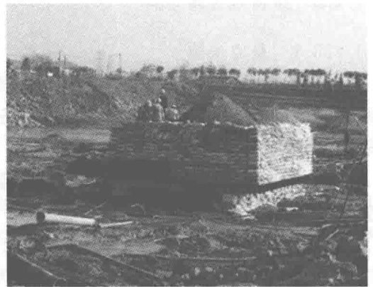
图 1.5 某单桩承载力现场加载试验
