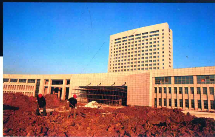
正在建设中的医院新大楼
