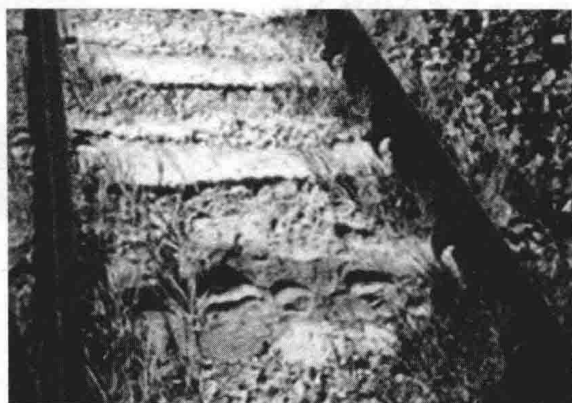
图 1-8 轨枕周围的干泥浆
