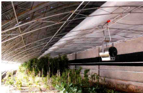
图 1—2 “朵蓝温室”采用双层保温技术和热风炉技术
