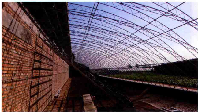
图 1-1 适应北方地区气候条件的大角度、双层覆盖的高寒越冬温室——“朵蓝温室”（摄影 张日高 ① ）
