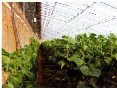
图2-3 后坡仰角大，水平投影小，采光好
