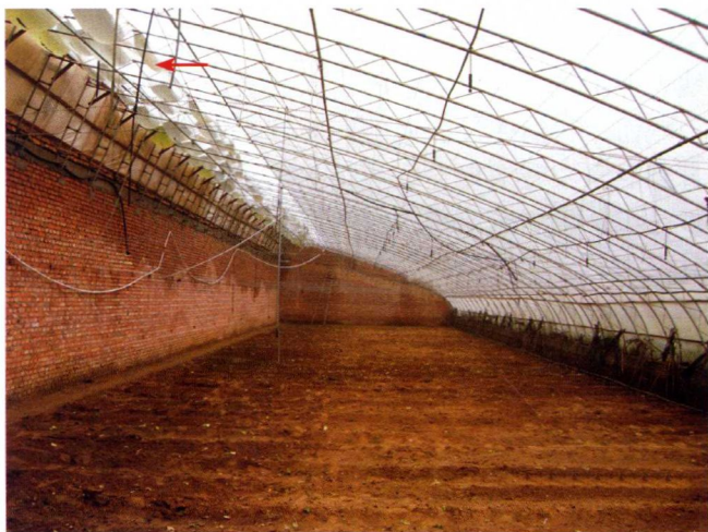
图2-1 前屋面顶部过平形成水兜
