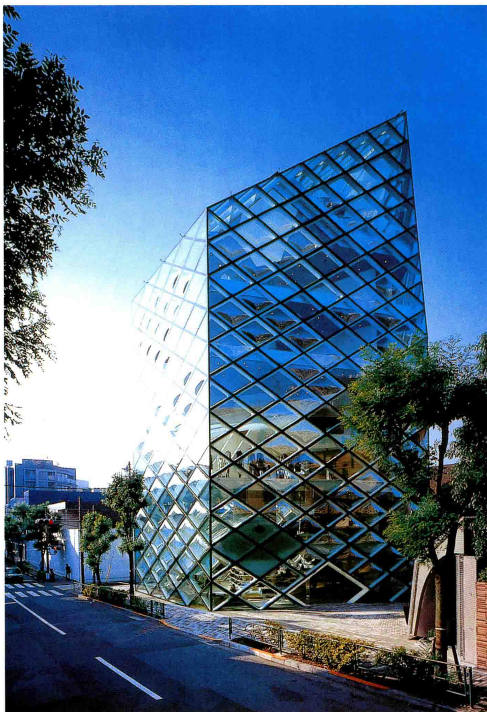
北侧立面全景 形成留有开放空间的街路
