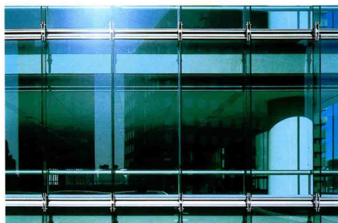
带玻璃肋的刚性玻璃幕墙
