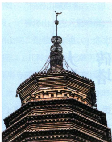
塔顶铁制塔刹及鸟形候风仪
