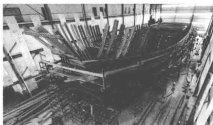
图1 水密隔舱福船制造技艺
