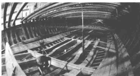
图1 水密隔舱福船制造技艺
