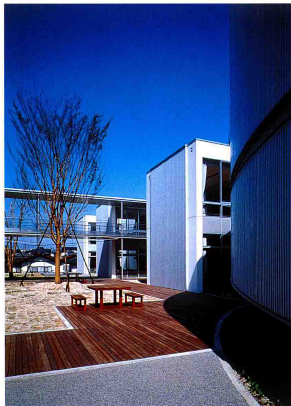
面对中庭一侧所见的住宅
