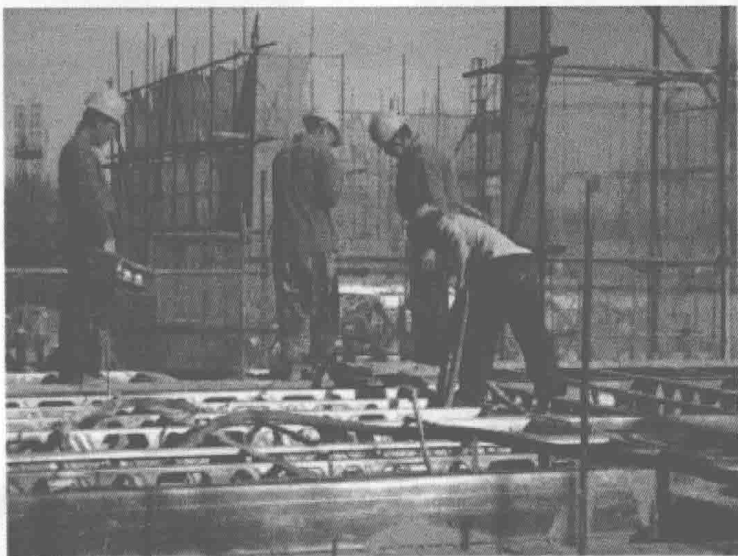
图 1-3 混凝土浇注现场
