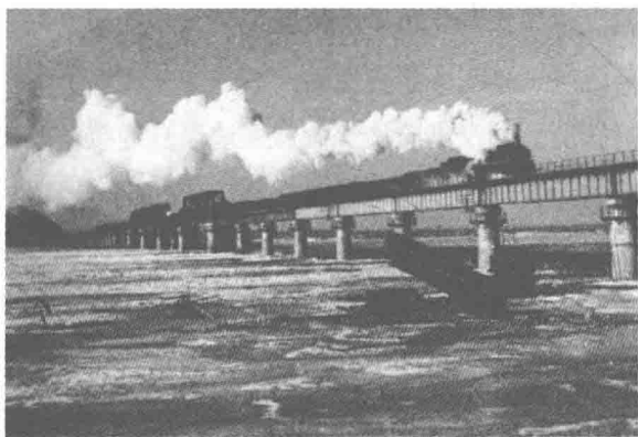
铁道纵队抢修的陶赖昭松花江大桥，有力支援了前线作战。（铁道兵档案图片）
