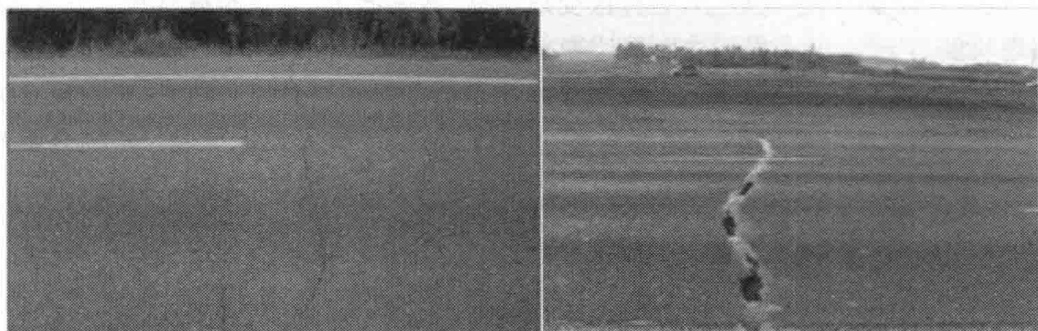
图 2-4 横向裂缝
