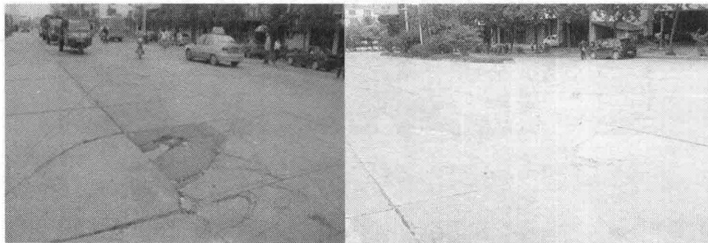
图 2-14 板角断裂
