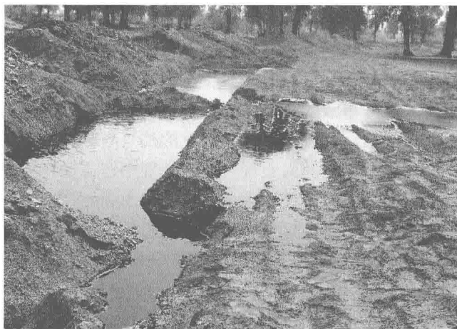
图 1-7 2011 年西部某油田输油管线腐蚀导致原油外漏
