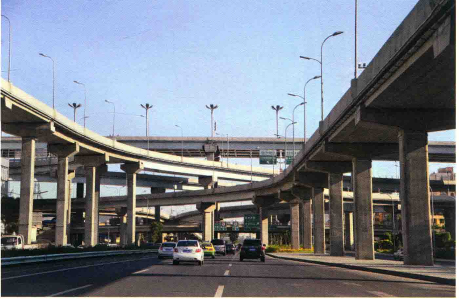
مشروع إعادة إعمار طريق تيان تزي بأورومتشي
