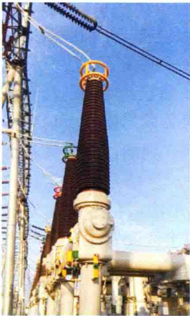
图 1-1 某线出线套管检测位置
