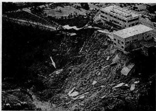
图 1-9 土体滑坡 the Vaiont Dam (1963) Italy
