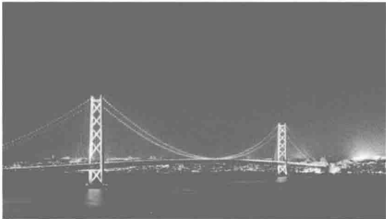
图 1.1-3 日本明石海峡大桥
