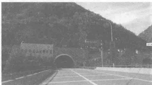
图 1-13 秦岭终南山隧道
