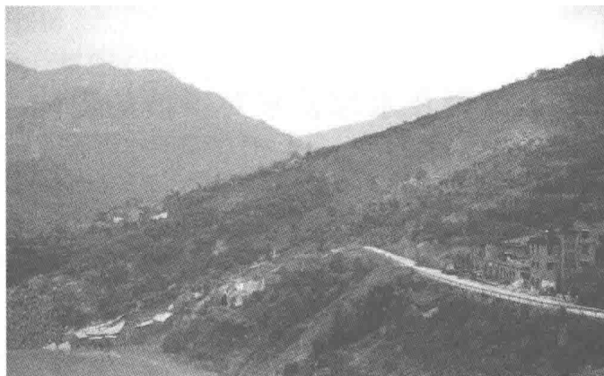
图 1.1.5 三峡库区秭归县杉树槽滑坡
