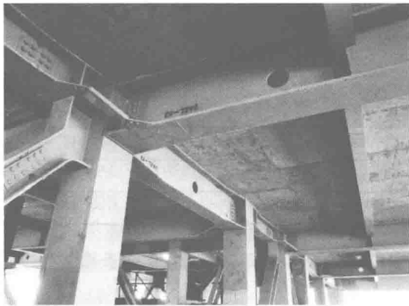
图 1-2 中国石油乌鲁木齐大厦钢梁开洞
