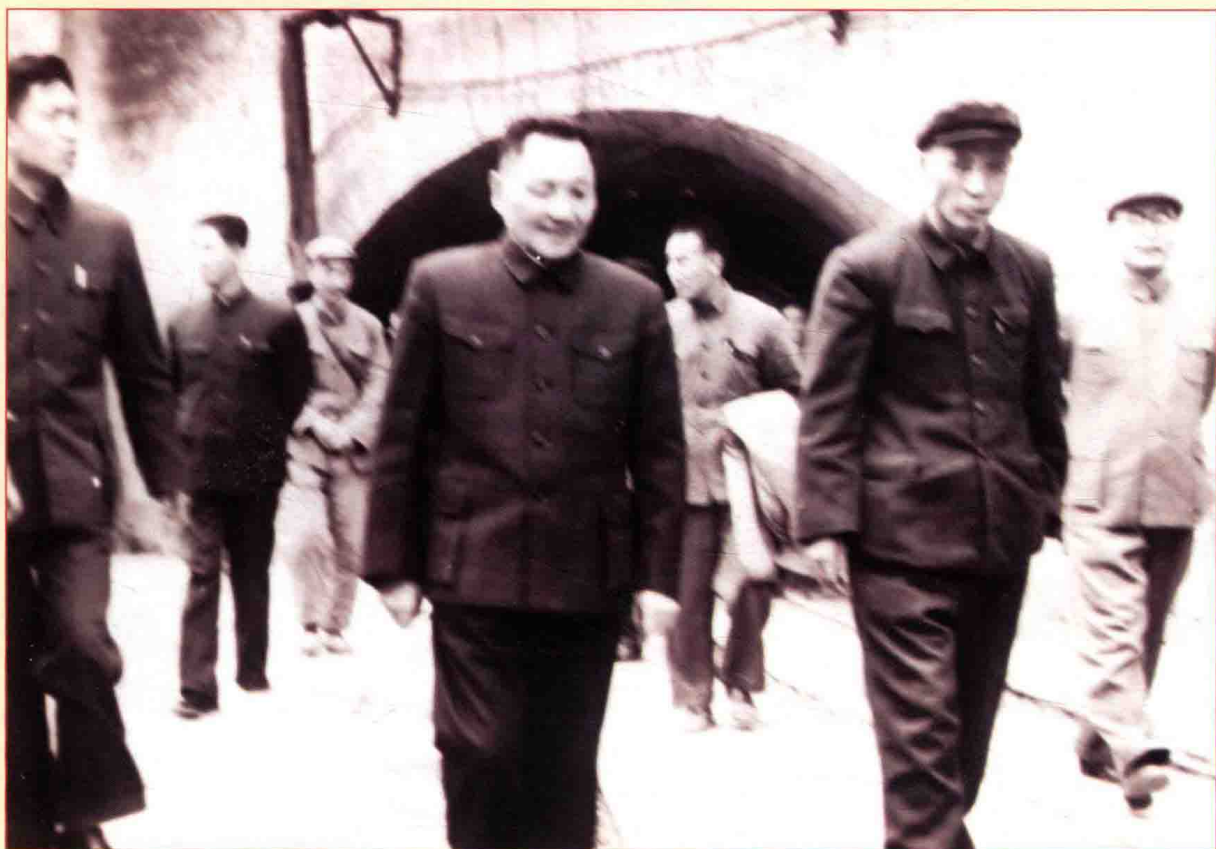
1965年11月23日，中共中央总书记、国务院副总理邓小平（中）在六枝视察贵昆铁路关寨火车站
