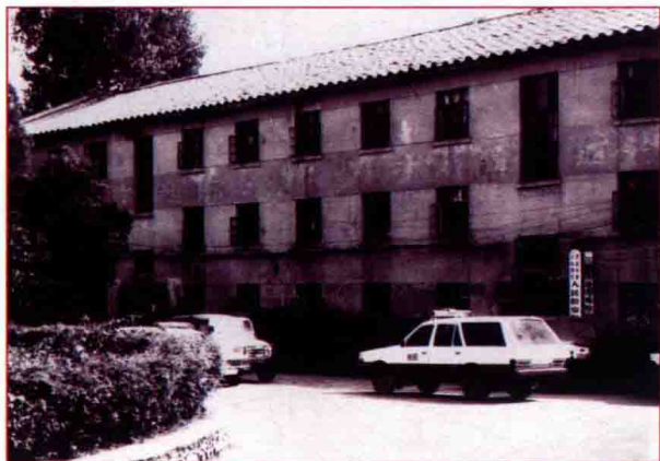
西南煤矿建设指挥部旧址
