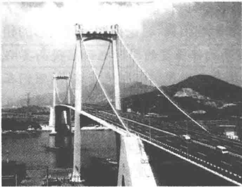
(c) 厦门海沧大桥
