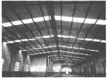
(b) 钢结构厂房
