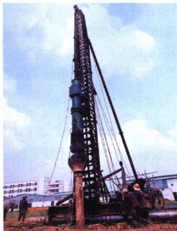
图 1-14 打入桩施工图片
