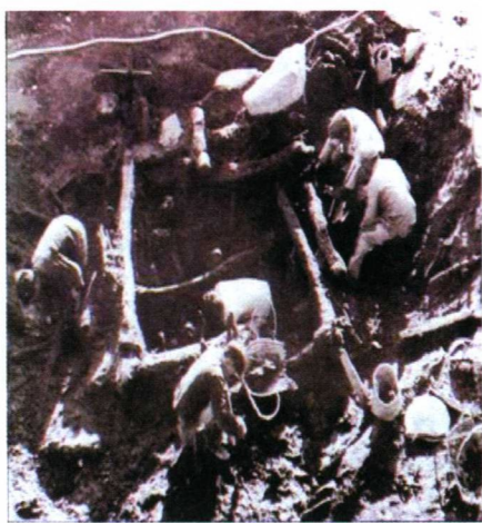
图 1-6 河姆渡第二文化层出土水井遗址 ——用桩作为挡土结构物的起源
