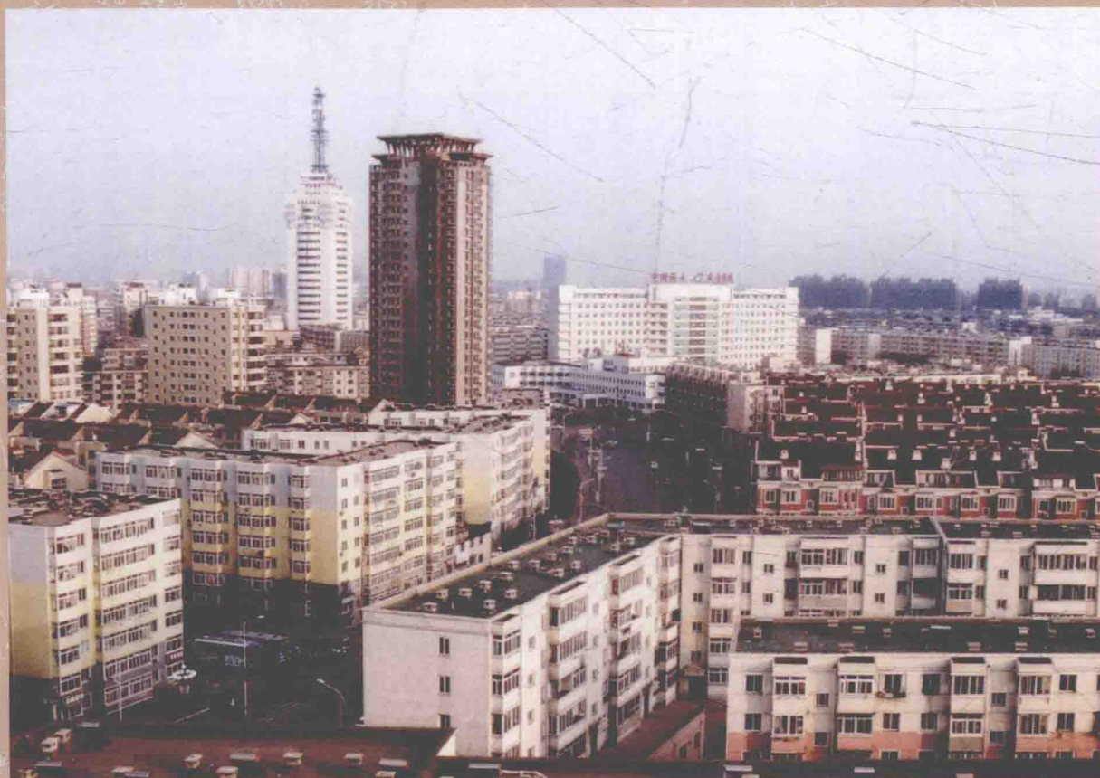
1996年，沈阳市铁西区艳粉居住区
