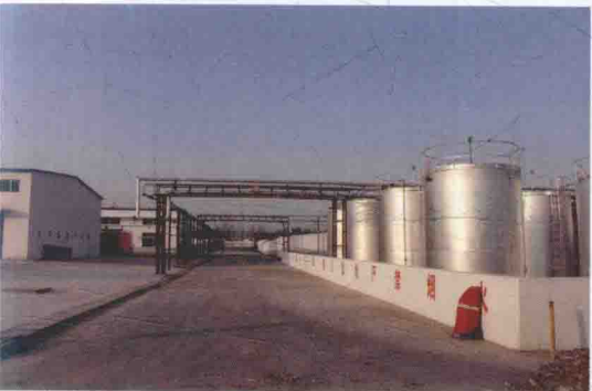
山东乐化漆业股份有限公司罐区
