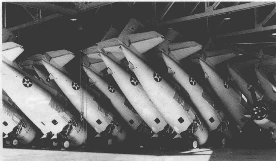
▲位于美国纽约州长岛的格鲁曼飞机工厂一景，堆积的战斗机机身彰显了流水线生产的强大生产能力。庞大的飞机产量是奠定二战美军航空兵胜利的一大基石。图中的机体属于F4F“野猫”战斗机，格鲁曼飞机工厂也是F6F“地狱猫”的“老家”。
