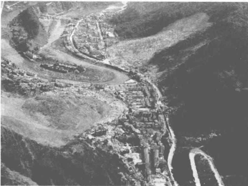
图 1.4 汶川地震后的北川县城
