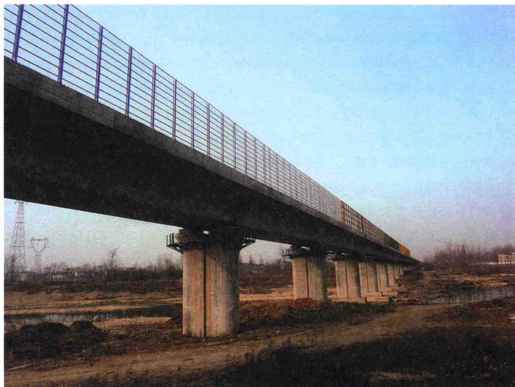
图 1-2 建设中的西安至成都客运专线(姬明周 2016 年摄)
