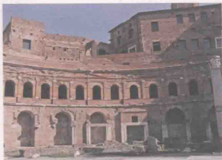
图拉真市场的砖包混凝土
