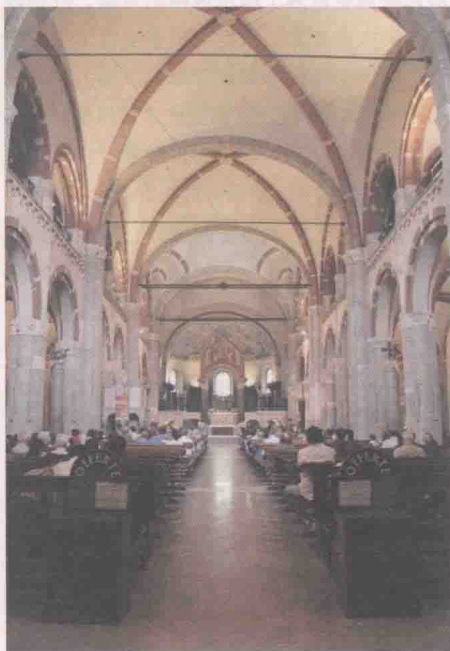
米兰圣安布罗吉奥教堂室内的交叉肋拱
