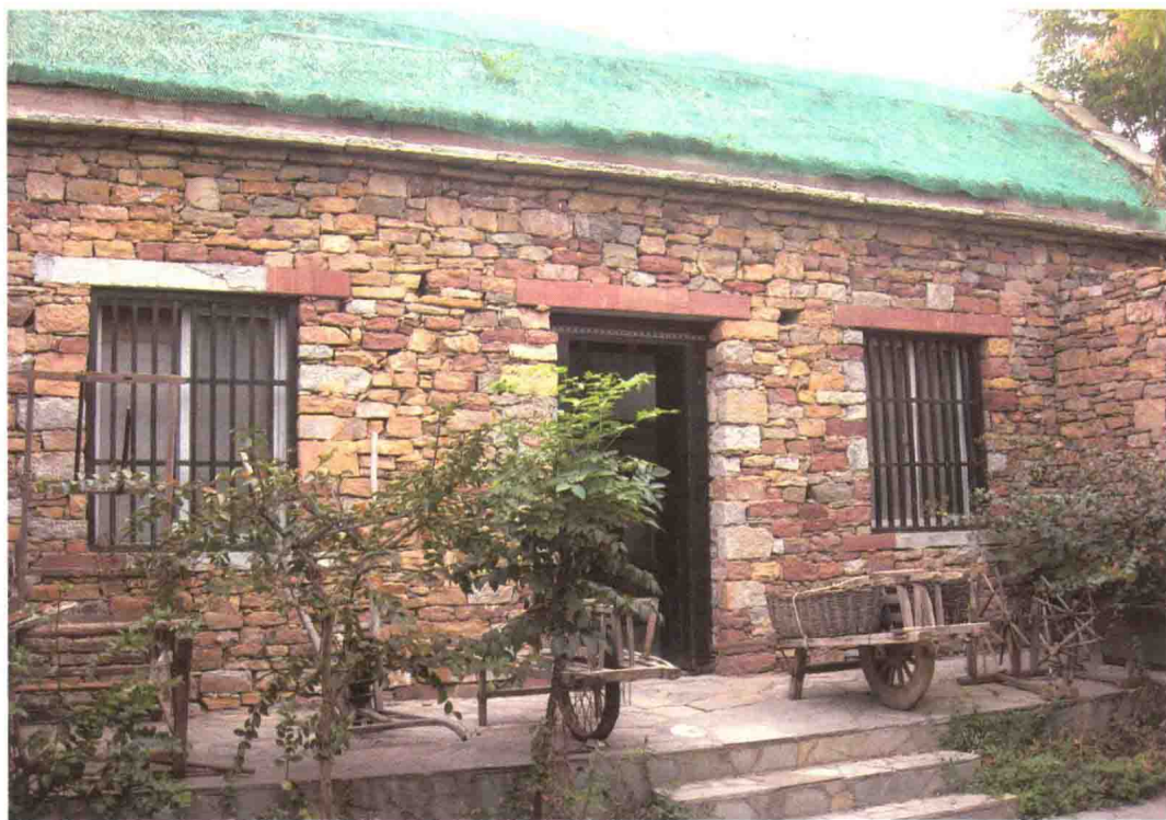
山东乡情展馆·木鱼石墙体、木棧窗、山草房顶（曲洪祎 摄）
