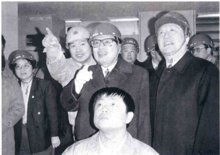
1997 年 1 月 17 日, 乔石在宝钢三期工程热轧厂了解 1580 热轧线试生产情况。
