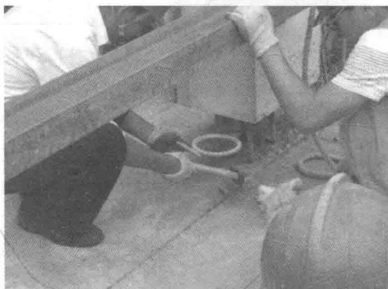
图 2-6 套筒钢筋位置校验
