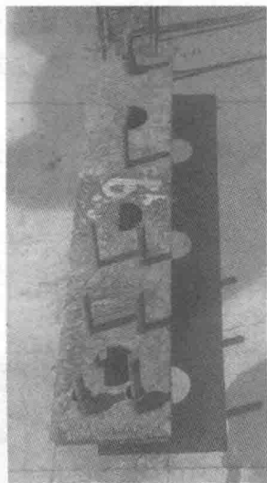
图 2-1 套筒钢筋位置校正
